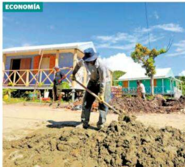
Las obras deberán acelerar para estar terminadas en cuatro meses. Foto: Corispa
